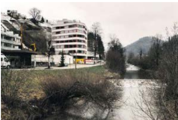
Der Neubau des Pflegezentrums Bauma neben der Töss
